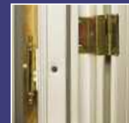
Tapées incorporées en PVC pour dormants monoblocs. Disposition N°6*
