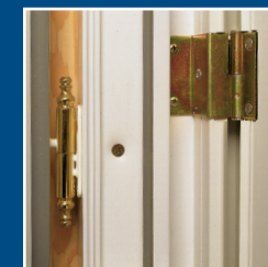
Tapées incorporées en PVC pour dormants monoblocs. Disposition N°6*
